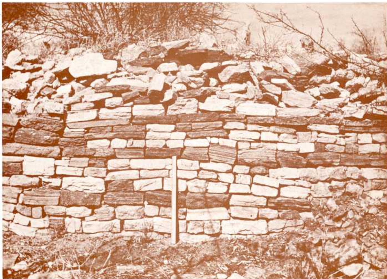
'n Voorbeeld van die pakwerk van afwisselende swart en wit klippe in een van die mure by die Matshêmbabouval.
